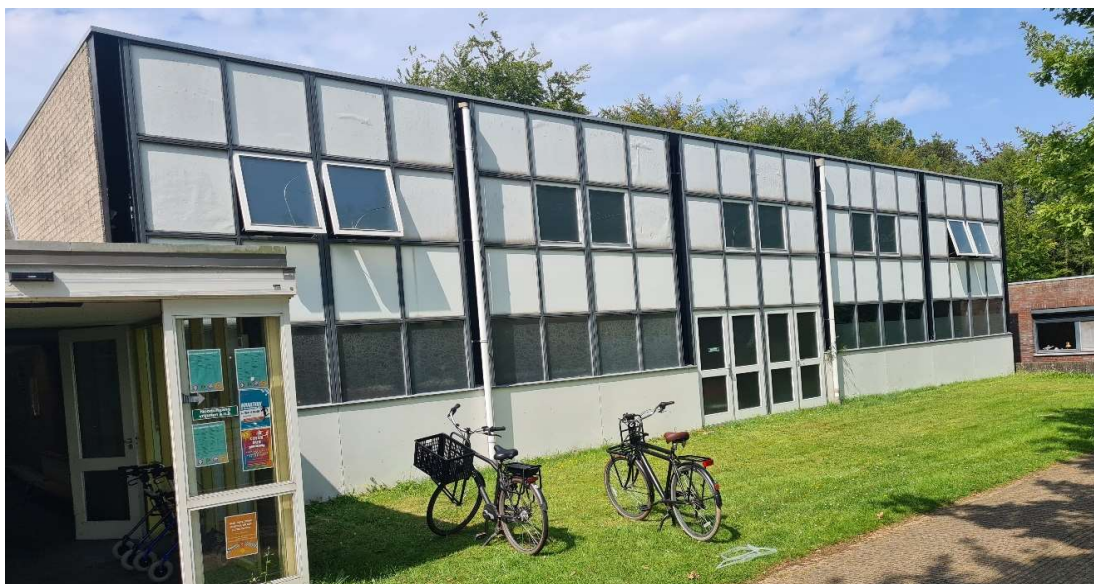
Figuur 3: buitengevel met hemelwaterafvoer
