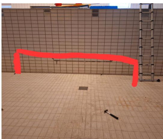
Detail opname holle tegels
