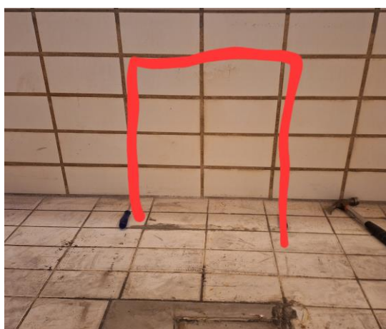
Detail opname holle tegels
