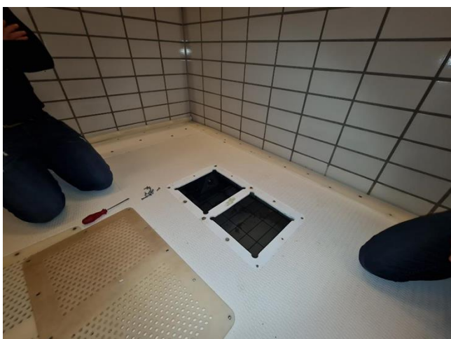
Afb. 5 & 6: Aanzicht van locatie in zwembad waar onder de bodemlift de doorvoerbuis van de kabels zit waar water naar binnen lekt (en bij vol zwembad naar buiten) incl. detailopname van lekwater wat uit de doorvoerbuis komt t.p.v pijl.
