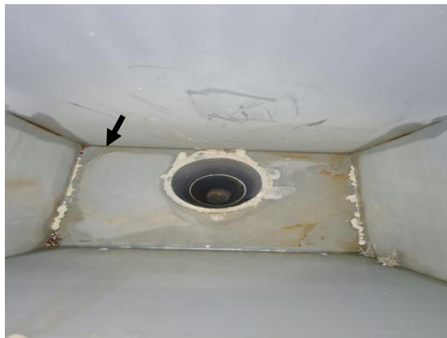
Afb. 1 & 2: Aanzicht van zwembad waar t.p.v pijl een scheur in de skimmer is geconstateerd incl. detailopname van skimmer waar t.p.v pijl een scheur zit.
