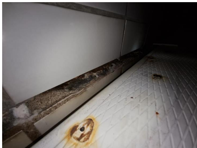
Afb. 3 & 4: Aanzicht van wand zwembad waar er openstaande voeg/tegelwand is incl. detailopname opening.
