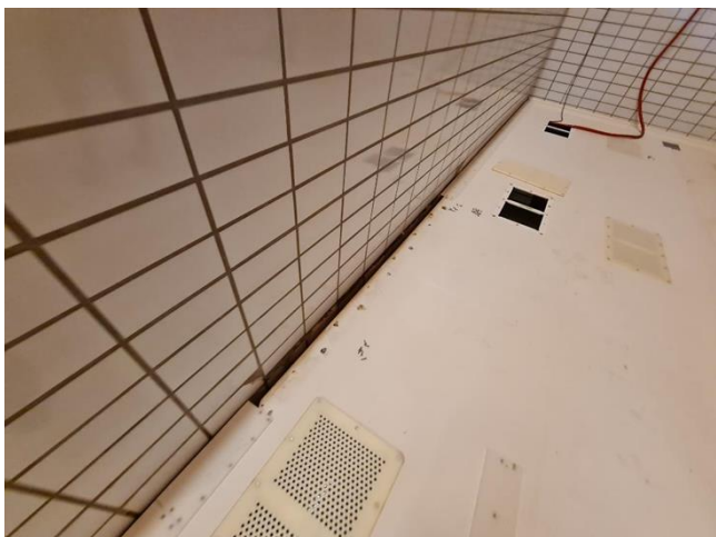
Afb. 3 & 4: Aanzicht van wand zwembad waar er openstaande voeg/tegelwand is incl. detailopname opening.
