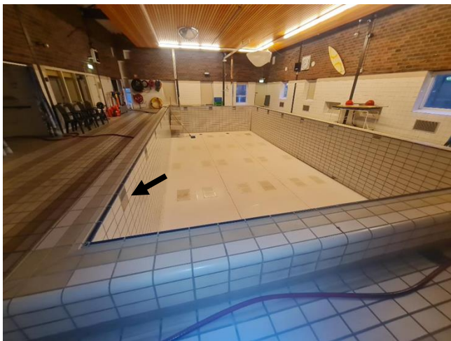
Afb. 1 & 2: Aanzicht van zwembad waar t.p.v pijl een scheur in de skimmer is geconstateerd incl. detailopname van skimmer waar t.p.v pijl een scheur zit.
