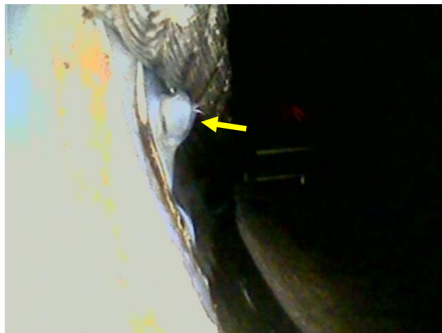
Afb. 7 & 8: Aanzicht van uitgevoerde inspectie in de doorvoerbuiskabel van de bodemlift incl. inwendige opname van lekkage in de doorvoerbuiskabel t.p.v pijl (stroomt grondwater naar binnen).
