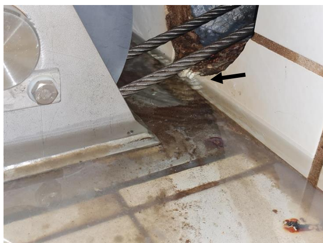
Afb. 5 & 6: Aanzicht van locatie in zwembad waar onder de bodemlift de doorvoerbuis van de kabels zit waar water naar binnen lekt (en bij vol zwembad naar buiten) incl. detailopname van lekwater wat uit de doorvoerbuis komt t.p.v pijl.
